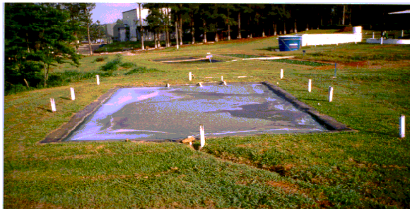
FIGURA 6: Vista de uma lagoa anaeróbia.
