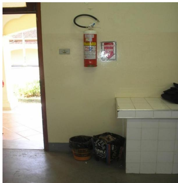
**FIGURA 19- Extintor PQS laboratório de química**
