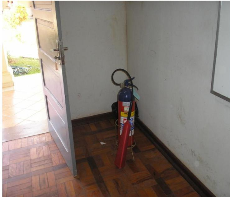
**FIGURA 18- Extintor de CO<sub>2</sub> laboratório de informática**
