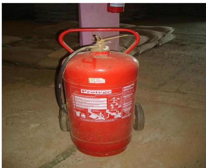
FIGURA 10 – Extintor de incêndio água pressurizada 50 litros
