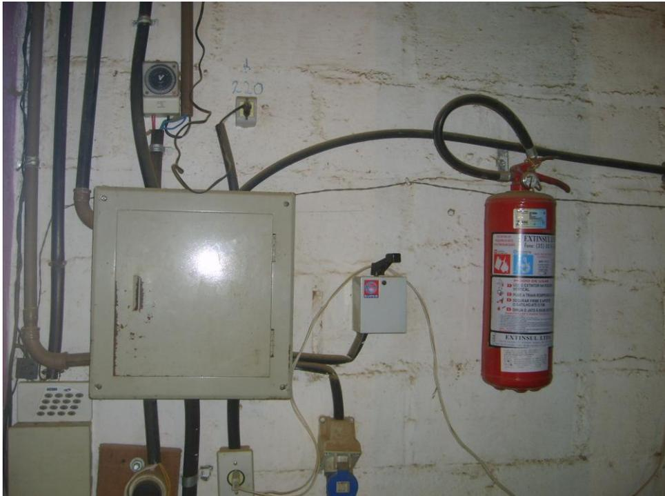
FIGURA 11 – Extintor incêndio pó químico seco (PQS)
