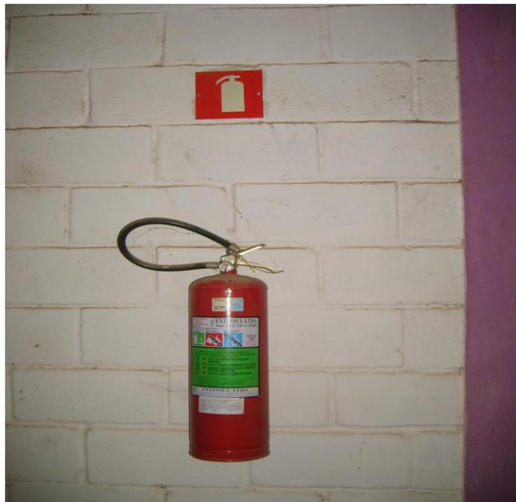
FIGURA 09 – Extintor incêndio água pressurizada 10 litros
